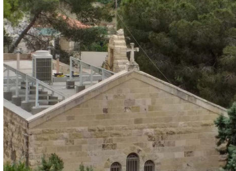
Die fertige Fotovoltaikanlage am Dach der Kirche
