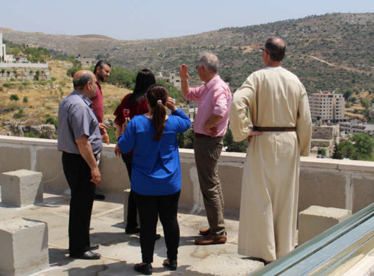
Besichtigung der Bauarbeiten am Dach der Schule mit Vertretern der Patriarchatschule in AinArik
