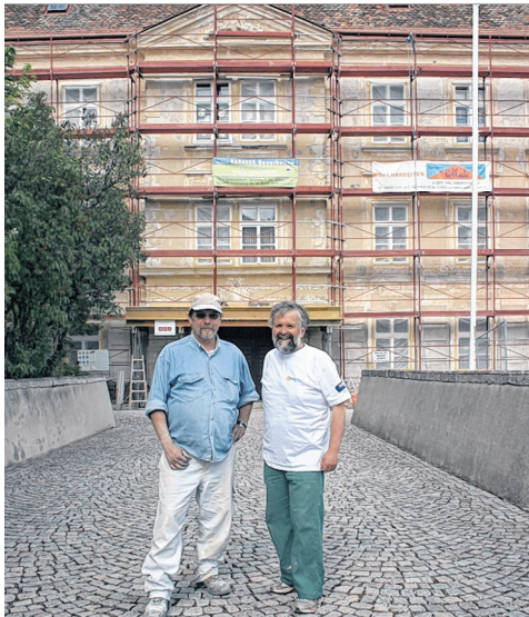
Eines der repräsentativen Häuser von Retz wird erneuert (v.r.): Stadtrat Walter Fallheier ist zufrieden mit dem Engagement der Männer am Bau. Polier Josef Rerucha ist das Bindeglied zur Bauleitung. Fotos: Karin Widhalm
